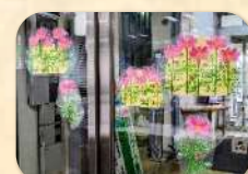
事務室入口衝突防止ステッカー 『コスモス』
